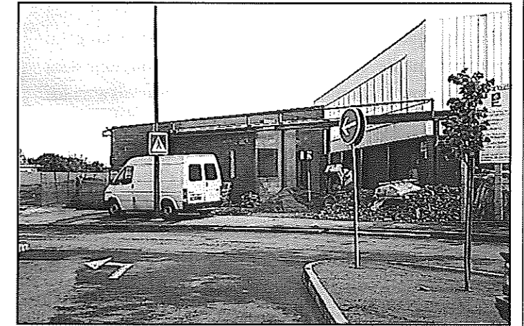
Travaux de la Maison de Quartier, adossée au gymnase.
